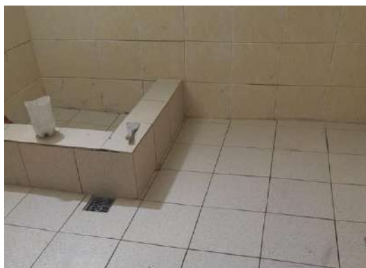
INSTALACIÓN CERÁMICA DE BAÑO
