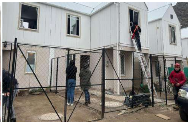
EMPRESA CONSTRUCTORA REPARANDO VIVIENDAS CON NECESIDAD INMEDIATA (FOTO 2)
