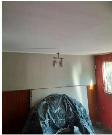
MEJORAMIENTO INTERIOR - CIELO LIVING COCHINOR
