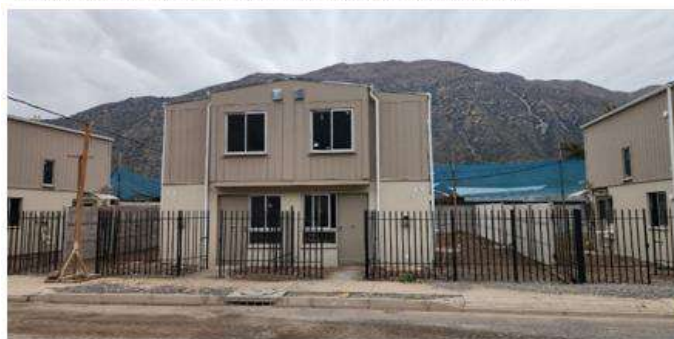
ESTADO ACTUAL DE LAS OBRAS
