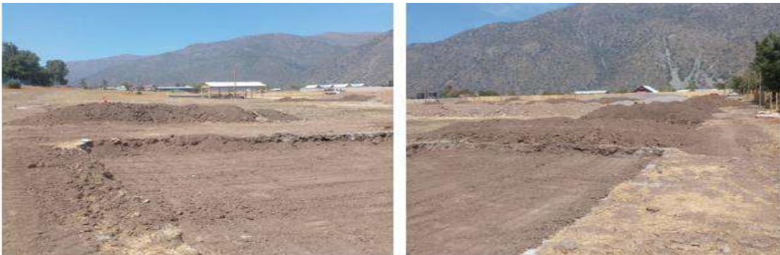
TERRENO DESPEJADO PARA INICIO DE OBRAS
