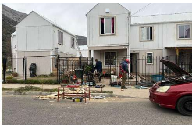
EMPRESA CONSTRUCTORA REPARANDO VIVIENDAS CON NECESIDAD INMEDIATA
