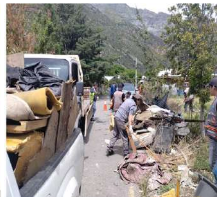
EQUIPO MUNICIPAL/ RETIRO DE ESCOMBROS SECTOR CANCHA VIEJA SAN GABRIEL
