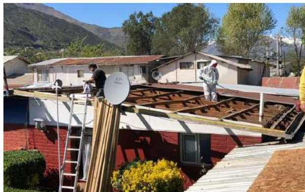
RETIRO DE ASBESTO DE CEMENTO VIVIENDAS IGNACIO CARRERA PINTO
