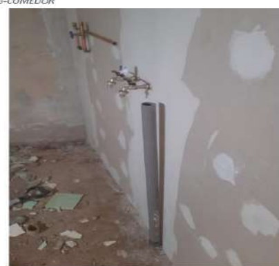
MEJORAMIENTO INTERIOR DE BAÑO
