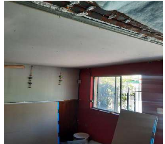
MEJORAMIENTO INTERIOR CAMBIO CIELO
