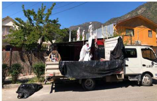
EQUIPO DE EMPRESA DE RETIRO ASBESTO CEMENTO
