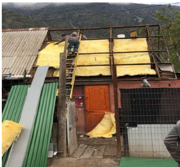
CAMBIO DE TECHUMBRE VIVIENDA BRISAS DEL RÍO
