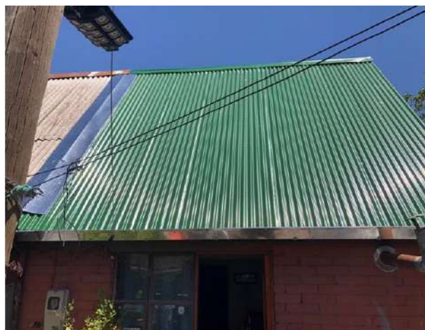
CAMBIO DE CUBIERTA TERMINADO-VIVIENDA BRISAS DE RIO
