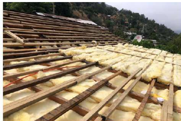
CAMBIO DE CUBIERTA IGNACIO CARRERA PINTO
