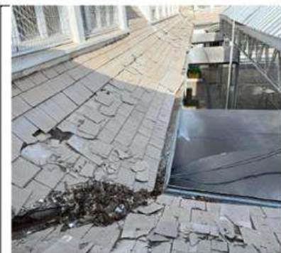
Figura 4. Tejas desprendidas
