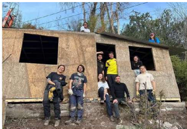
CONSTRUCCIÓN DE MEDIAGUAS VIVIENDA VECINO LAGUNILLAS
