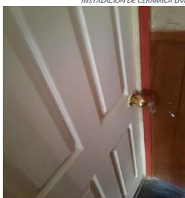
MEJORAMIENTO INTERIOR- CAMBIO DE PUERTA
