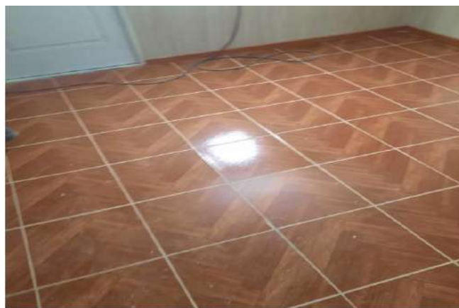
INSTALACIÓN DE CERÁMICA LIVING-COMEDOR
