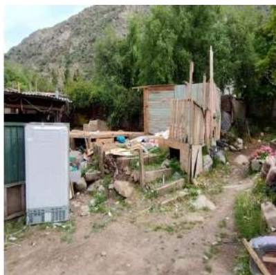
RECUPERACIÓN DE ESPACIO/ RETIRO DE ESCOMBROS CAMINO AL VOLCÁN SAN GABRIEL
