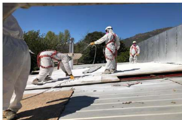
RETIRO ASBESTO DE CEMENTO VIVIENDA IGNACIO CARRERA PINTO
