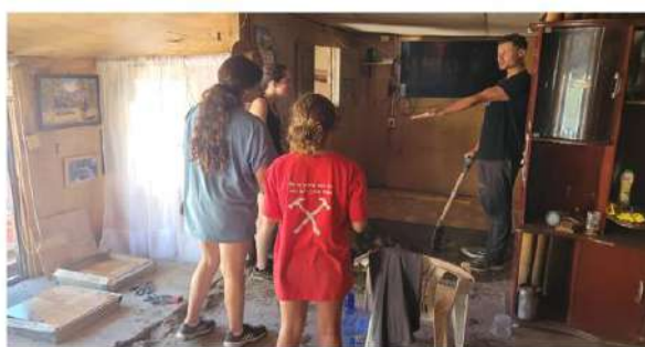
HABILITACIÓN DE PISO EN VIVIENDA DE LOS MAITENES
