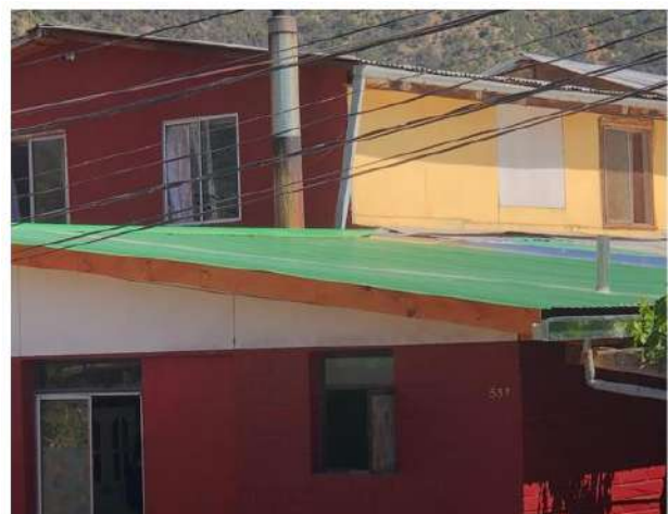
CAMBIO DE CUBIERTA TERMINADO - IGNACIO CARRERA PINTO
