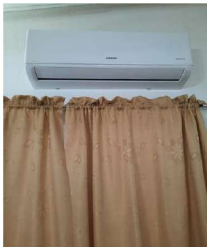
RECAMBIO POR AIRE ACONDICIONADO
