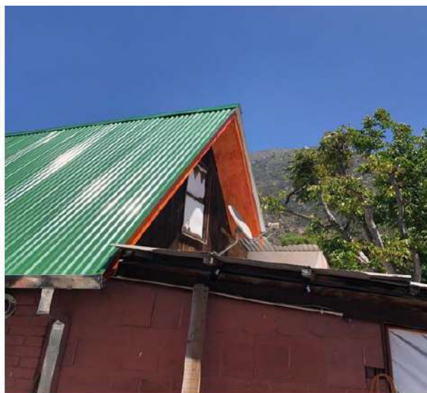
CAMBIO DE CUBIERTA TERMINADO- VIVIENDA BRISAS DEL RÍO
