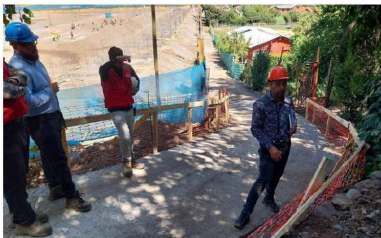
ARREGLO DE CAMINO PARA EL ACCESO DE FAMILIAS COLINDANTE AL PROYECTO DE VIVIENDA
