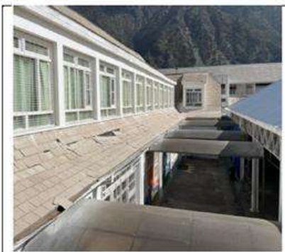
Figura 3. Tejas desprendidas
