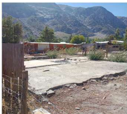
RECUPERACIÓN DE ESPACIO/ RETIRO DE ESCOMBROS SECTOR CANCHA VIEJA SAN GABRIEL
